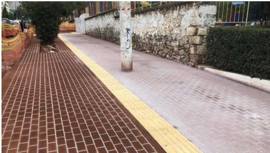
Εικόνα 2. Σταθερό, συνεχές και επιμελές αρμολόγημα (πηγή: https://www.michanikos-online.gr/ )
